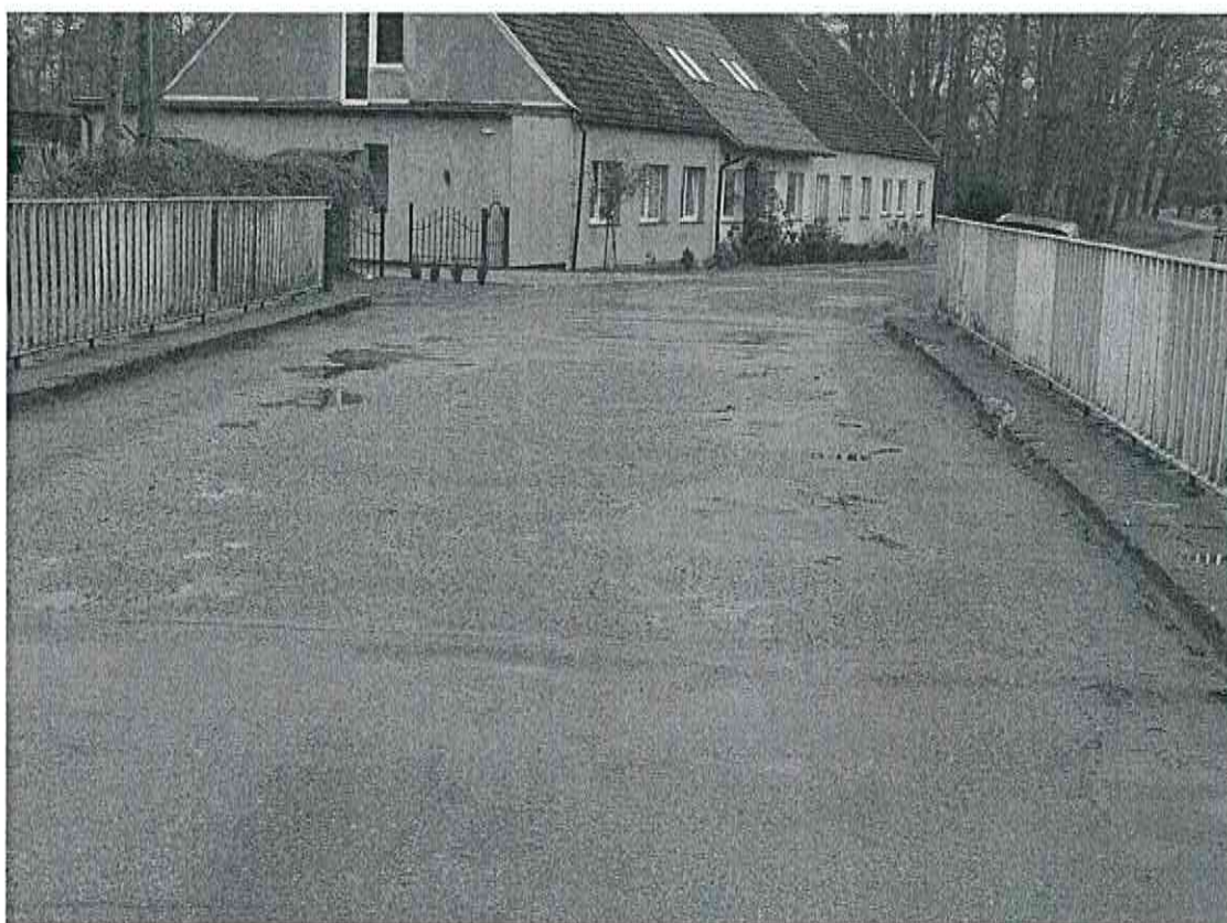
Fot. 2 Jezdnia na obiekcie.
