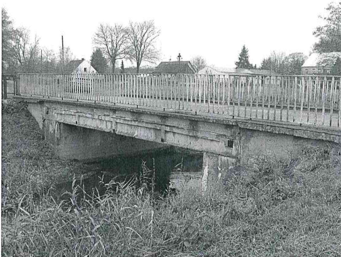
Fot. 1 Widok na obiekt od strony napływu
