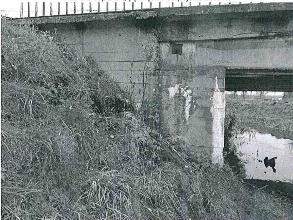
Fot. 10. Skarpa przy skrzydle Brak wzmocnienia skarpy może spowodować obsuwanie się gruntu nasypu.
