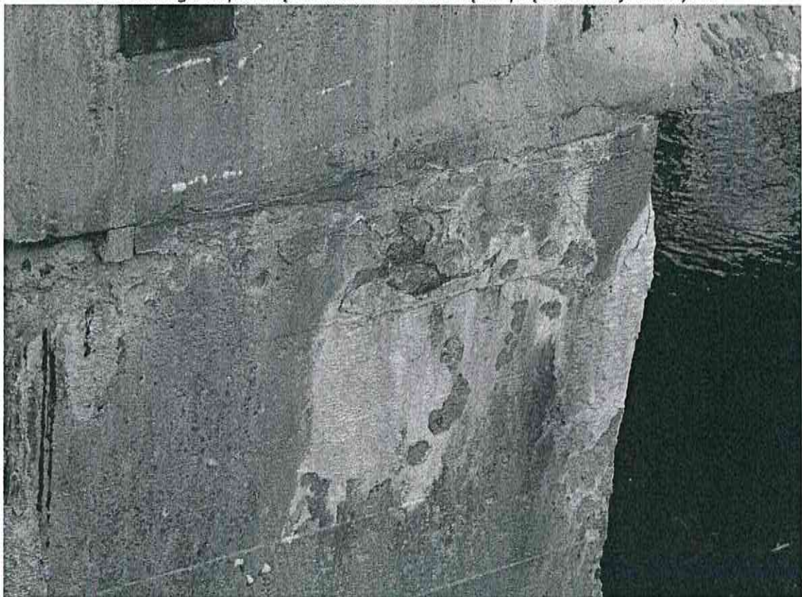
Fot. 10 Przyczółek obiektu
